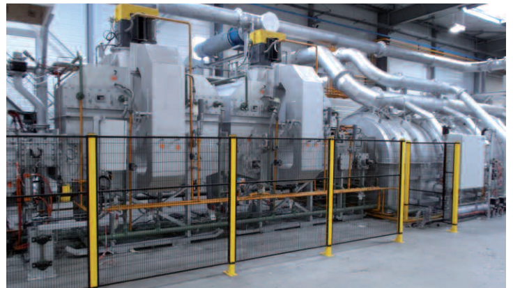
Kontinuierliche Glühanlage für Edelstahl
